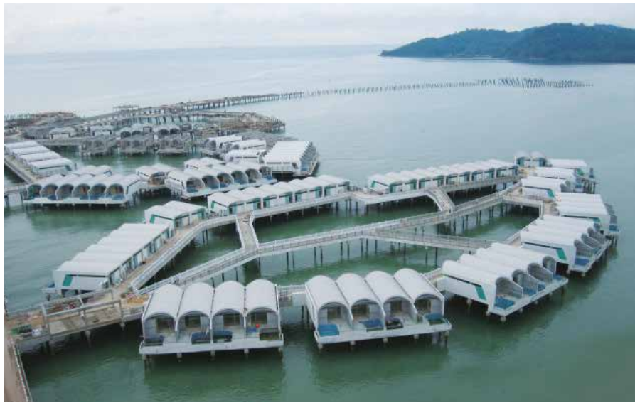
The Hibiscus : Site Progress 大红花水上度假屋 施工进度
